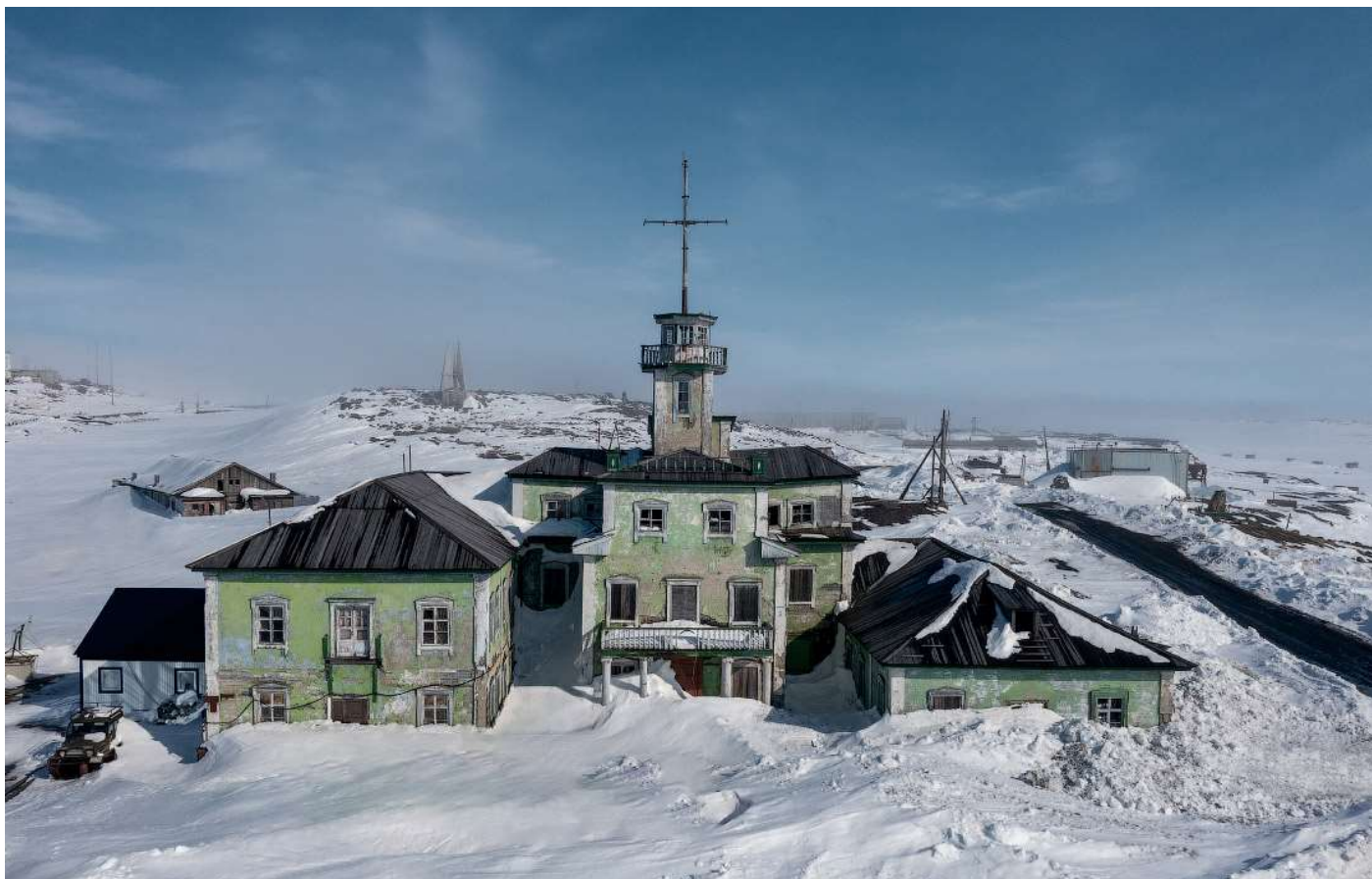
Фотография здания морского порта (источник: https://teletype.in/@gelio/dikson )
