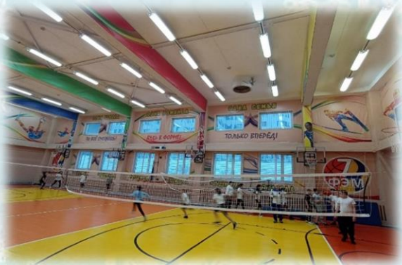
ремонт спортивного зала ТМК ОУ «Дудинская средняя школа №7»
